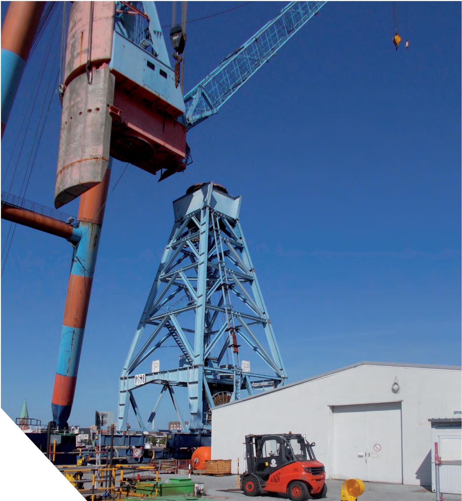
Konecranes hat für die German Naval Yards Kiel GmbH das Drehkranzlager eines Portaldrehkrans gewechselt und dafür den kompletten rund 430 Tonnen schweren Oberkran mit einem Schwimmkran angehoben.
